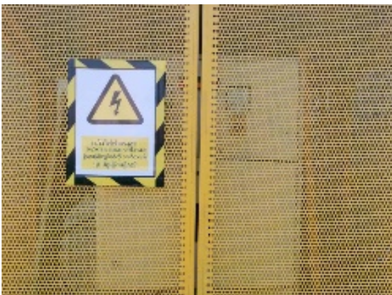
ภาพที่ 39 ติดตั้งป้ายเตือนอันตรายบริเวณตู้ไฟฟ้าชั่วคราว
