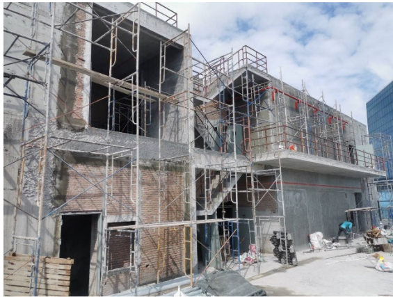
ภาพที่ 58 ใช้นั่งร้านตามมาตรฐานขณะทำงานบนที่สูง
