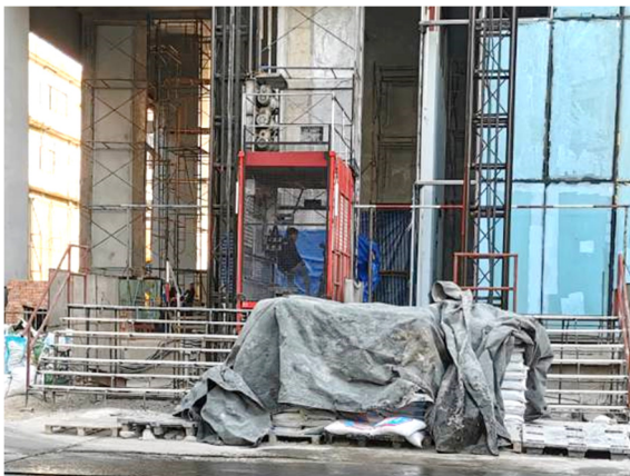
ภาพที่ 21 การลำเลียงวัสดุก่อสร้างด้วยลิฟท์ขนของชั่วคราว
